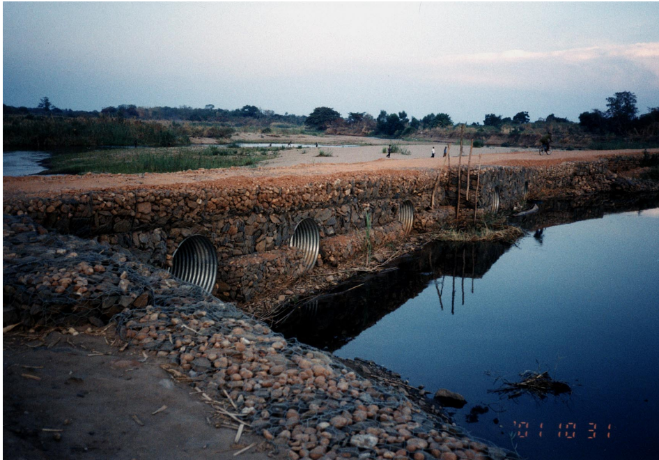
道路兼用の土堰堤
