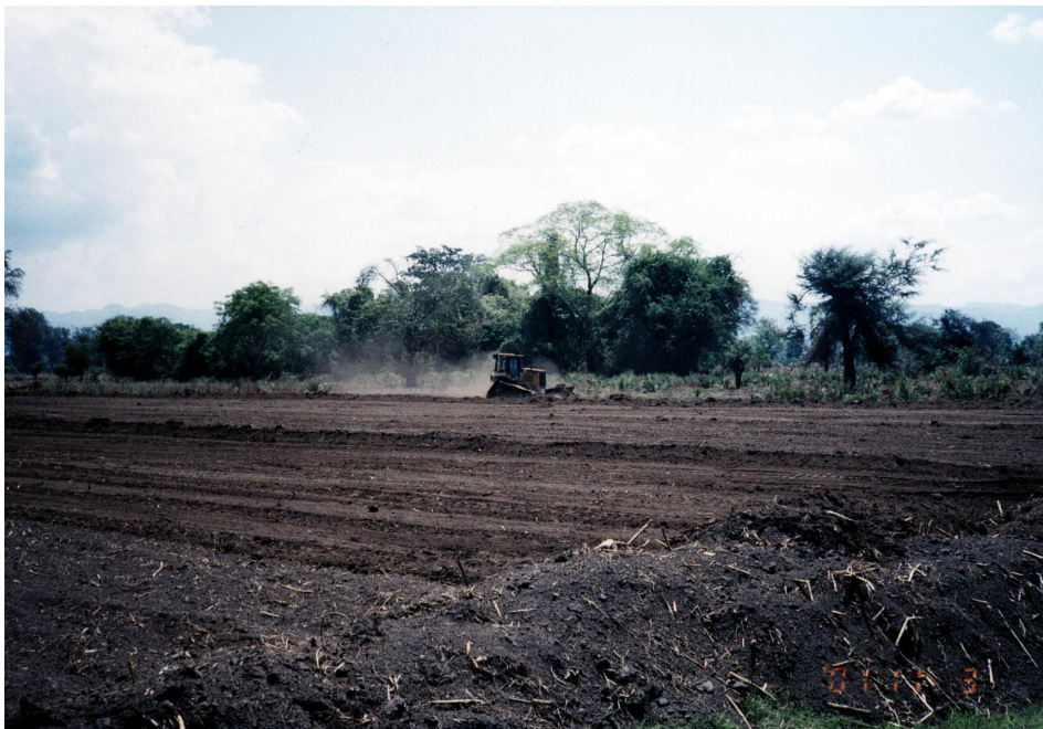
10. BWANJE BALLEY IRRIGATION SCHEME(日本) KR2 資金のブルによる圃場均平工事
