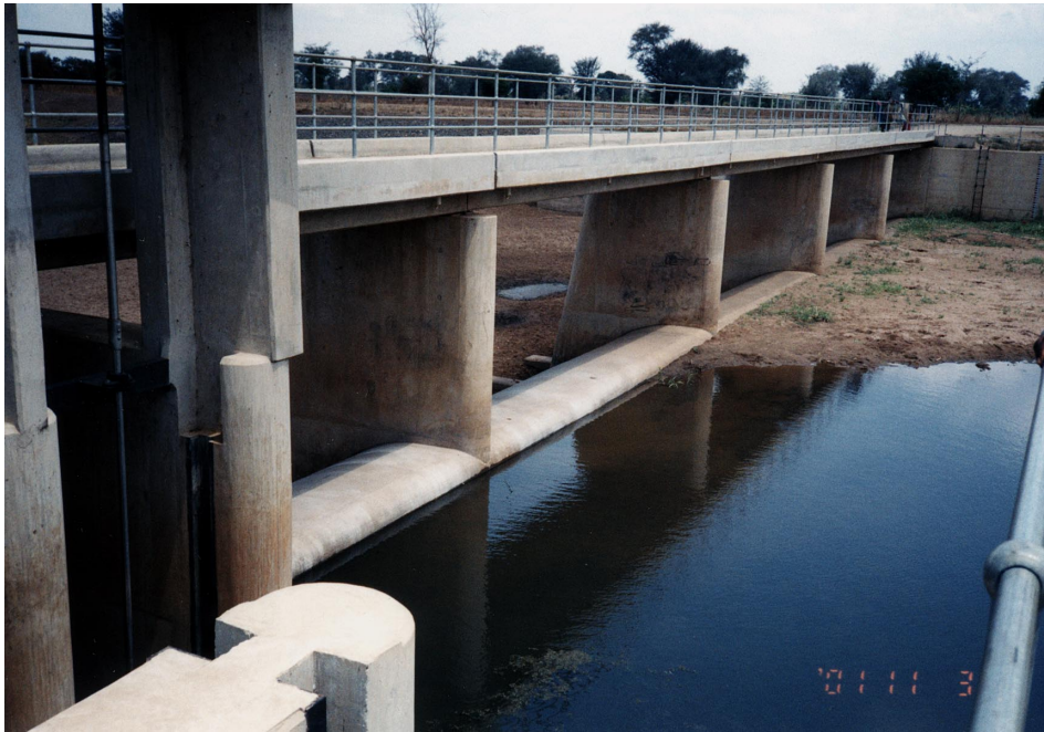
全量取水中のコンクリート頭首工
