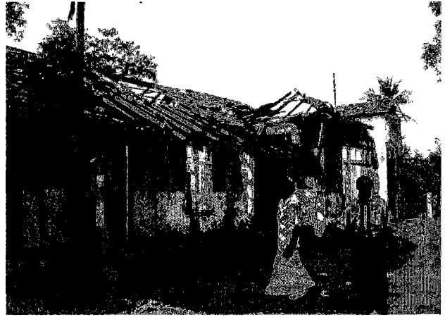
破壊された県病院 (3) (チャワカッチェリ、ジャフナ県)
