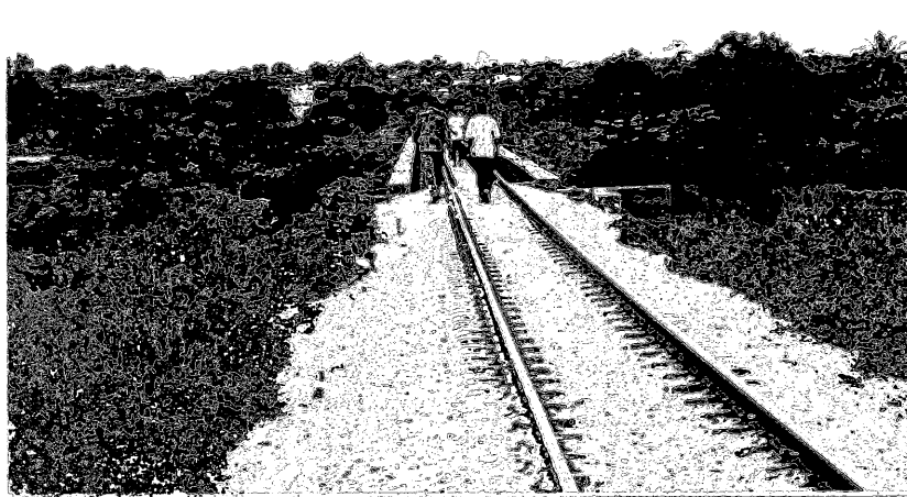
写真 2 - 1 アグボビル市内の鉄道線路
