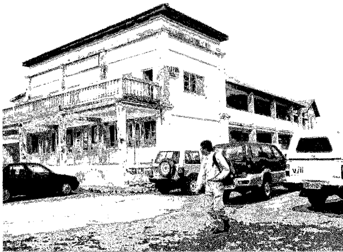
アグボビル県庁舎
