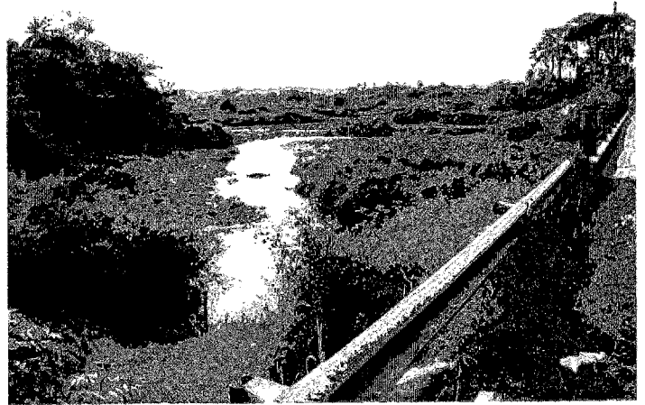
道路橋下流側
