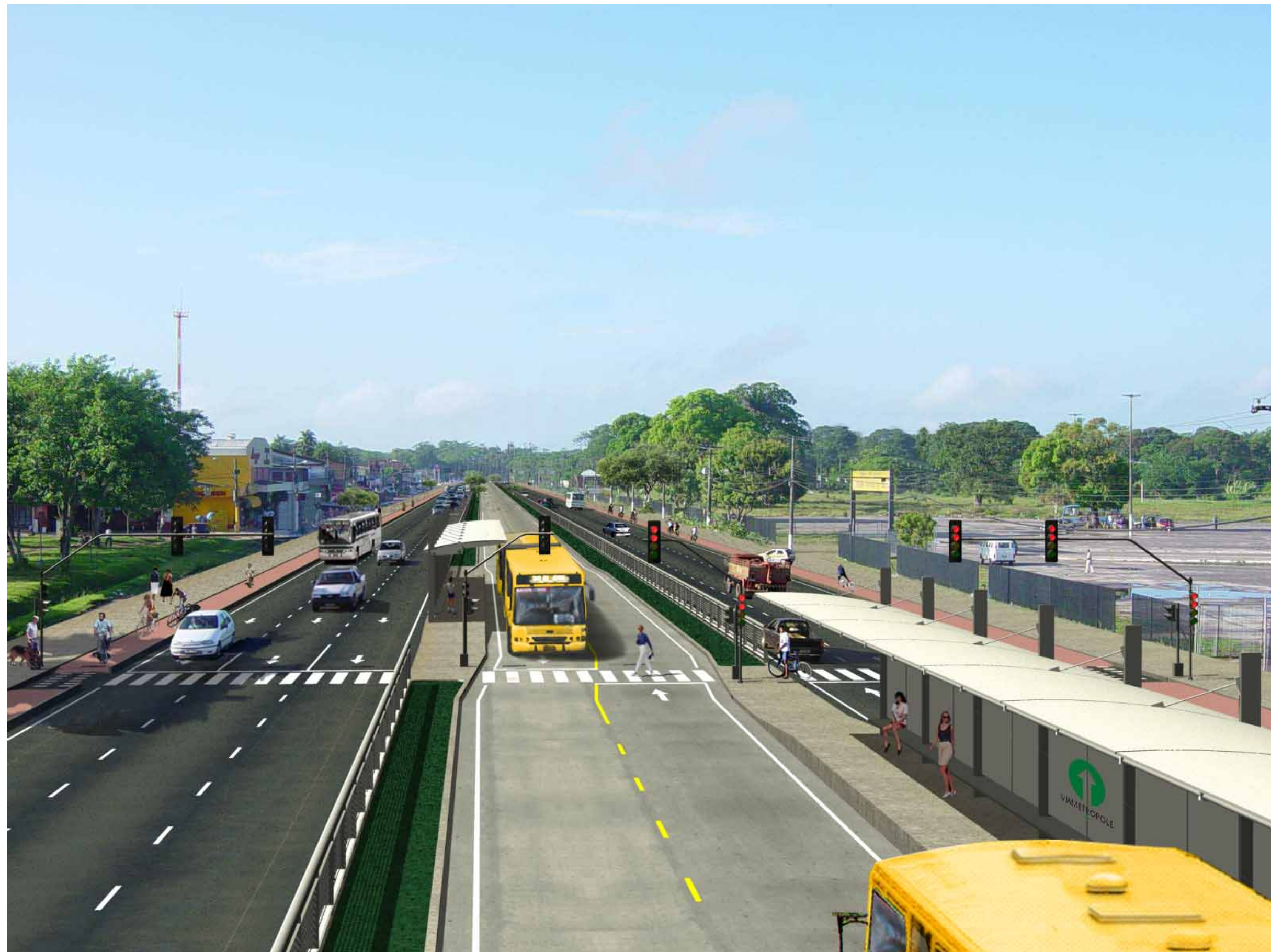
Canaleta Exclusiva para Ônibus na Rodovia Augusto Montenegro
