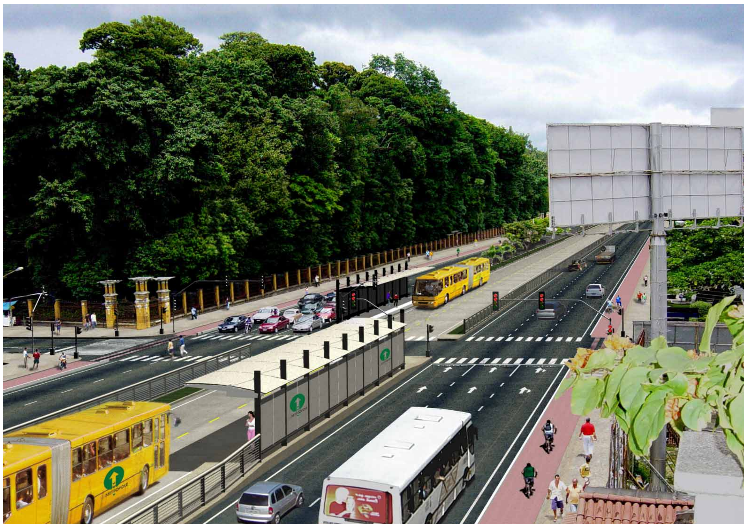
Canaleta Exclusiva para Ônibus na Avenida Almirante Barroso
