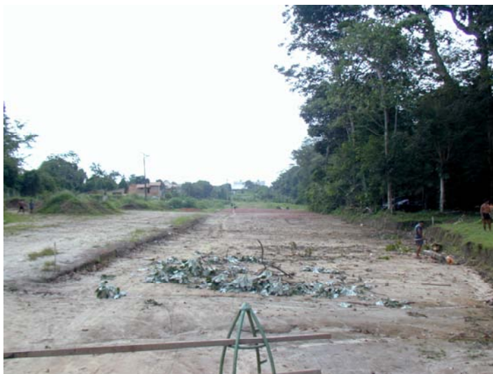
Photo D-4 Under Construction of AVENIDA PRIMEIRO DE DEZEMBRO
