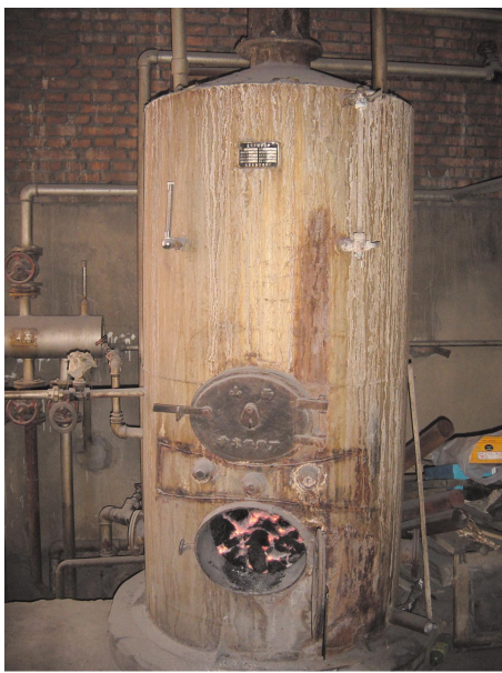
回収注射器の焼却炉
