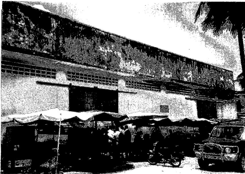
写真 2 タケオ州商業局倉庫外部
