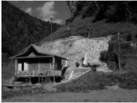
Tha Le Oo Powerhouse
