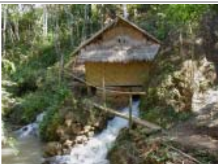
発電所位置 洪水位より上の発電所位置 チャイエウ 村
