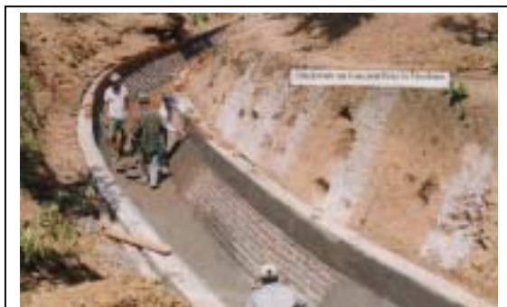
ブロック積み水路 センパイ村
