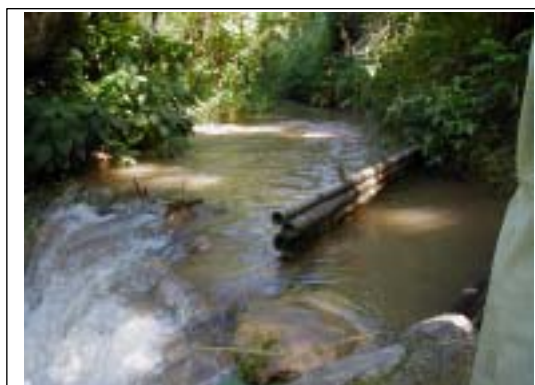
自然地形の利用例 滝のある地形を利用し、硬い河床、低洪水位、少量の堆砂を狙う。竹製の壁により浮遊物の流入を防ぐ。タレウー村。
