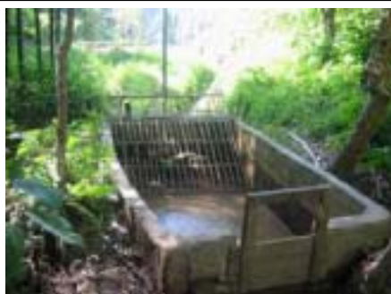
ヘッドタンクと竹製除塵スクリーン
