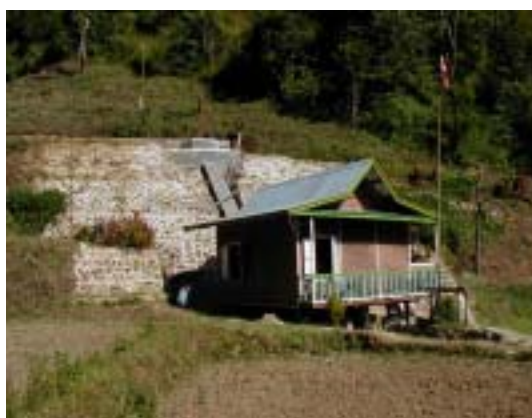
2階建て発電所 上階はオペレータ室、下階は水車・発電機を 設置。 タレウ村
