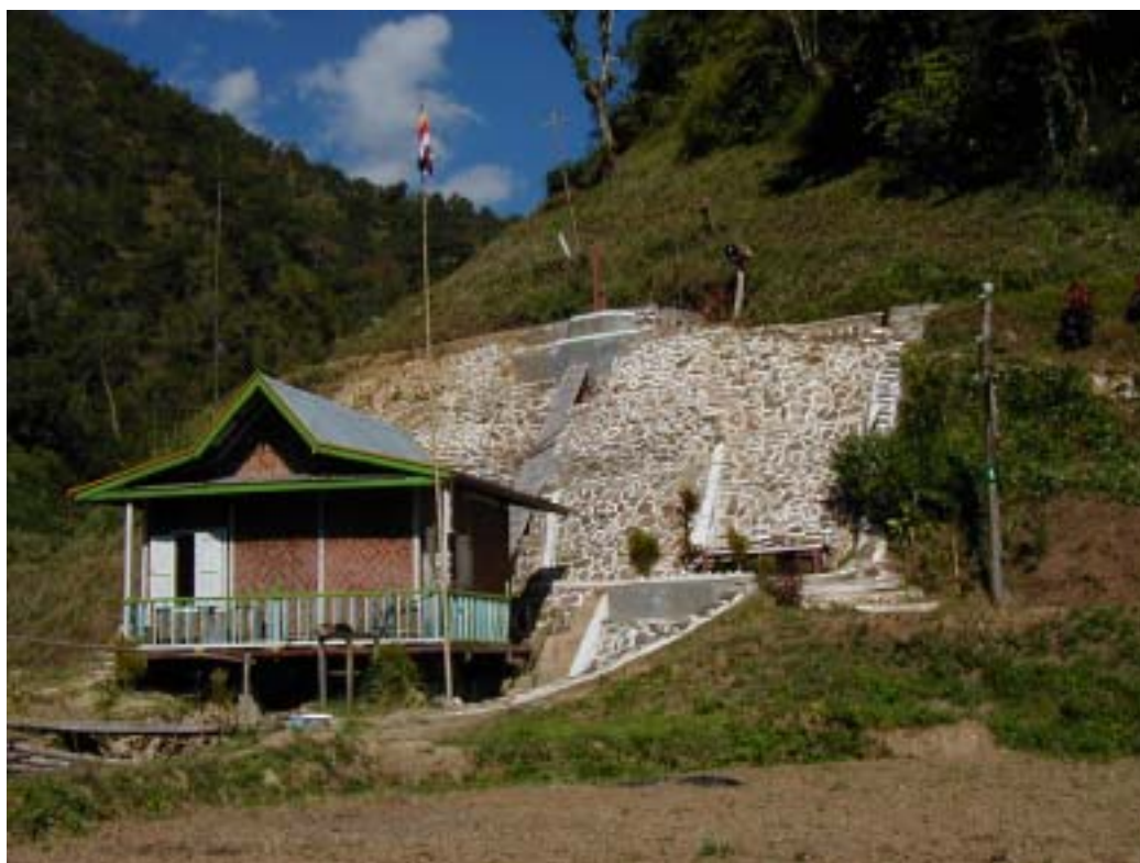
石積みによるペンストックの斜面保護例 タレウ村
