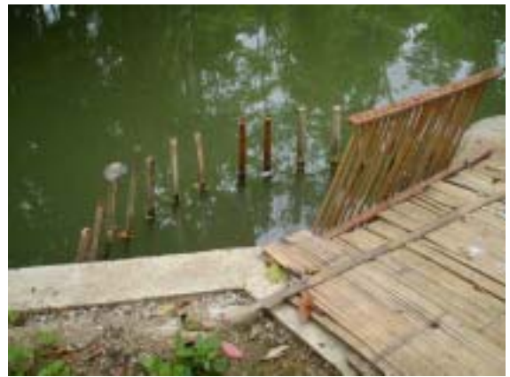
取水口と除塵スクリーンの例
