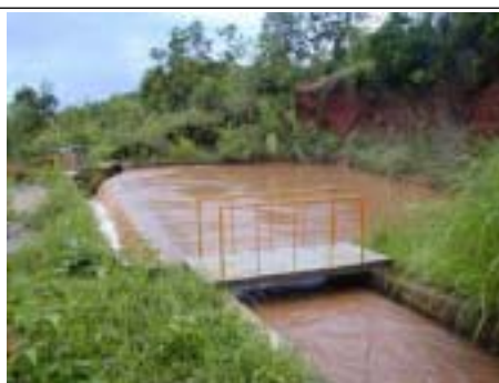
越流路とヘッドタンク
