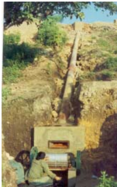
建設中ペンストックと発電所 Source: RDHG
