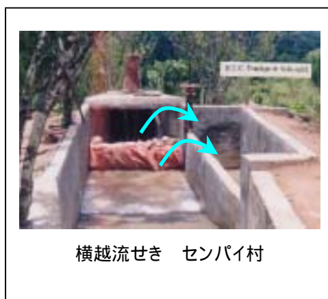
過剰流入を越流させる横越流せき ポピン
