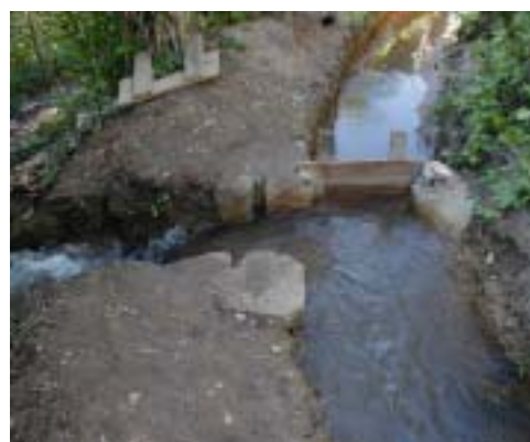
余水路を持つ素掘り水路
