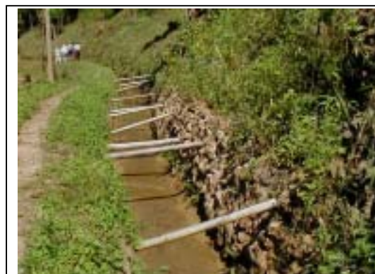
水路（建設中） タレウー村
