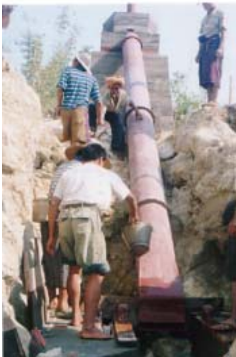
設置中のペンストック ソンボ村 Source: RDHG
