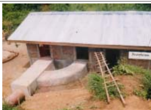
発電所とペンストック 建設中、 センパイ村 Source: APT
