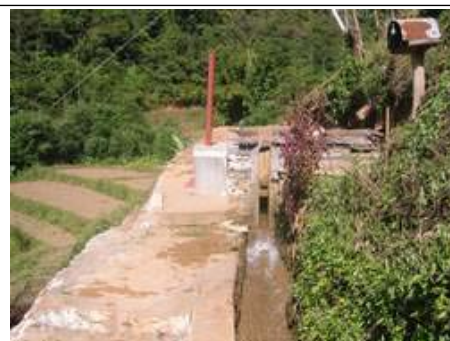
ヘッドタンクの排砂路
