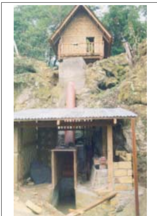
アンカーブロックによるペンストックの固定 ハンポ村、建設中
