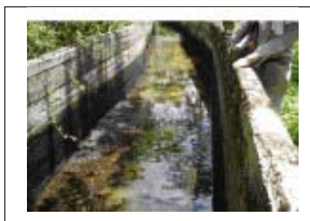
図 4.3.3 漏水箇所のスラブと基礎の浸食状況
