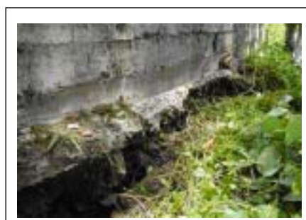
図 4.3.3 漏水箇所のスラブと基礎の浸食状況
