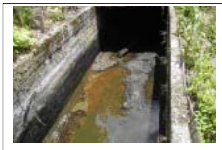
図 4.3.4 水路の床スラブと壁との付け根の浸食状況
