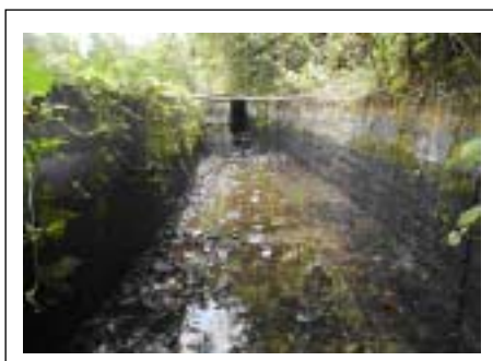
図 4.3.2 導水路内の堆砂と堆砂深さの測定
