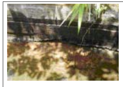
図 4.3.4 水路の床スラブと壁との付け根の浸食状況
