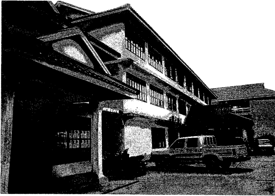
③ 社会労働福祉省の管轄下にある Center for Skill Development の外観
