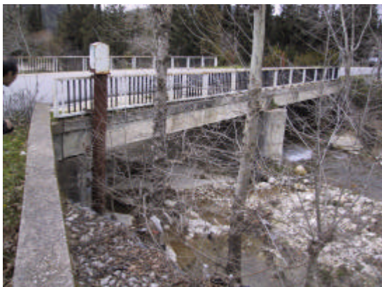
11. 沿岸部流域の既存水位計
