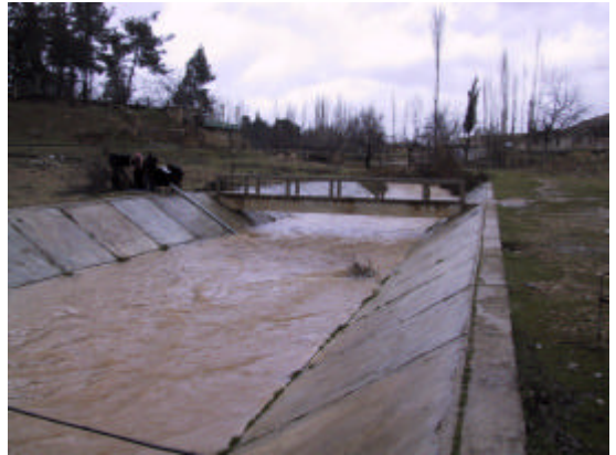
8. プロ技で実施したバラダ川の河道整形と水位計
