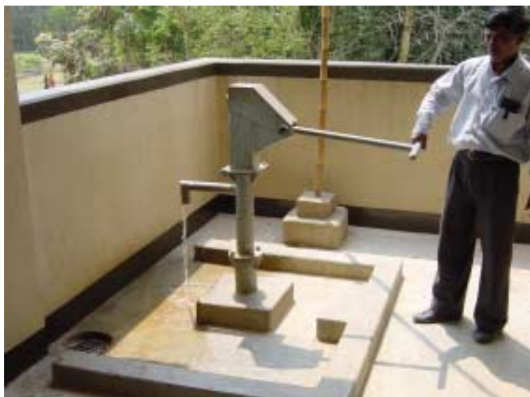
同シェルター2階に設置された手動ポンプ （サイクロン襲来時においても安全で衛生的な水を供給できる）
