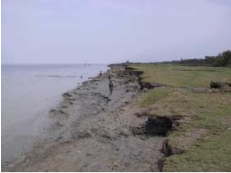
Hatia 郡の西側河岸の浸食状況(南側より北方を望む)
