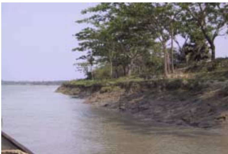
Banshkhalia 郡 Sangu 川左岸の浸食状況(船上下流側より上流側を望む)
