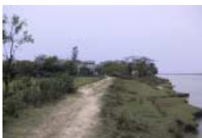
シェルターを上流側より望む
