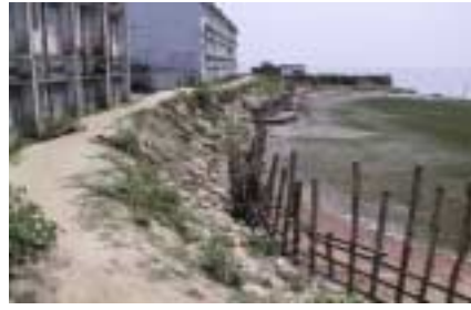
西側河岸の法面保護の状態
