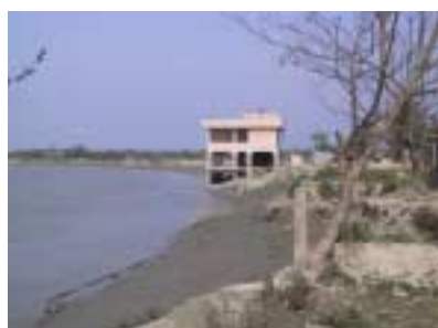
シェルターを下流より望む
