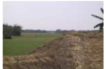
堤防上より No.39 を望む
