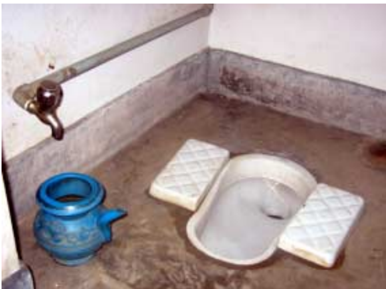
同シェルター内の2階便所 （雨期及びサイクロン襲来時において、 屋上の天水受けより、手洗い用の 水が供給される）
