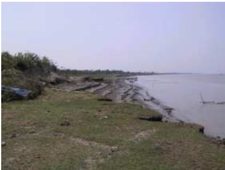
Hatia 郡の西側河岸の浸食状況(北側より南方を望む)
