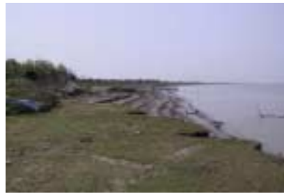
西側河岸を北側より南方向を望む
