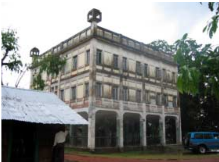
サウジ・アラビアにより建設されたシ ェルター兼初等学校 (1994 年竣工)
