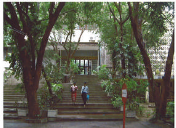
ヤンゴン大学図書館。1階の床高さは1m以上あり、他の施設も同様である。本計画でも雨水や地面からの輻射熱を考慮し、床高さを設定している。
