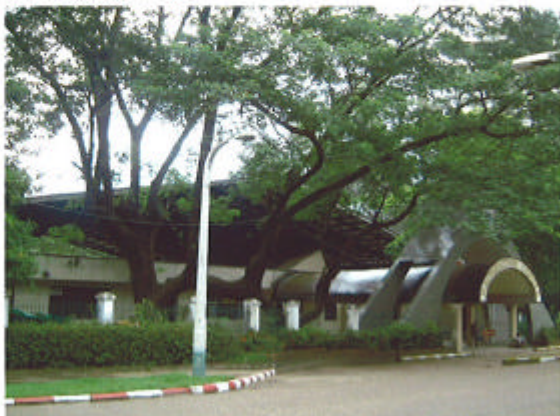
ヤンゴン大学大ホール。鉄骨造の大屋根の下は外気に面し、十分な換気が得られる。本計画でも適切な通風、採光が得られるよう断面計画を検討している。
