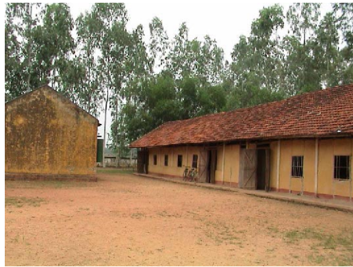
TN-3 Nam Hoa 1 既存校舎外観
