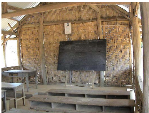
TQ-10s Xuan Quang (Sub school) 木造仮設校舎内部
