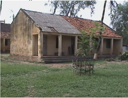
BG-8 Dong Lo 2 既存校舎外観
