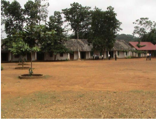
TQ-2 Vinh Loc 既存校舎外観
