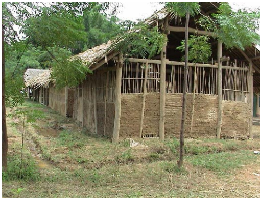
TN-11 Yen Trach 2 既存校舎外観(木造仮設校舎)
