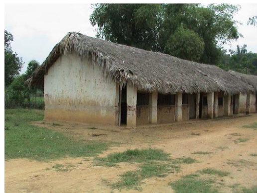
TN-17 Binh Thanh 既存校舎外観(レンガ造に草葺き屋根)
