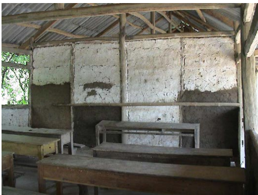
TQ-5s Thuong Am (Sub School) 木造仮設校舎内部(天井、建具無し)
