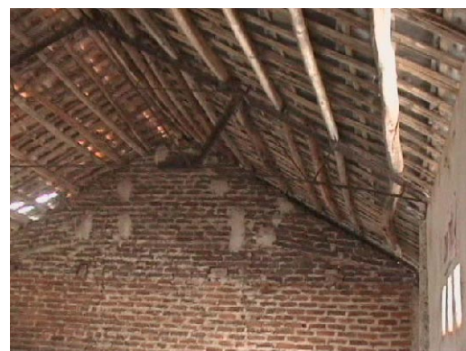
TN-16s Hong Tien (Sub School) 教室内(天井は無く屋根に損傷が目立つ)
