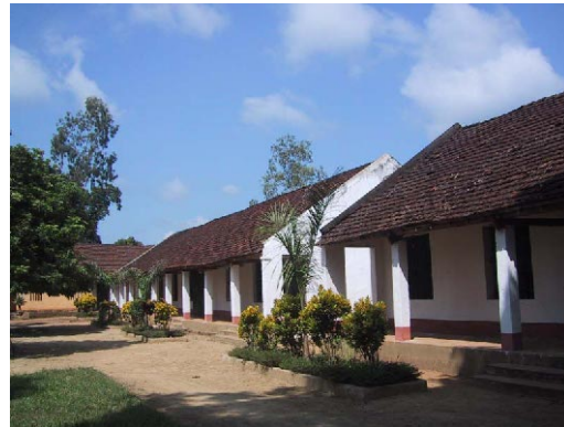
PT-15 Vo Mieu 3 既存校舎外観
