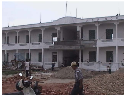
PT-5 Det 新築中の2階建て校舎
