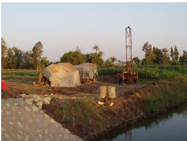
本計画浄水場建設予定地の地質調査状況
