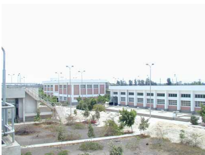
既設カフルサクル浄水場 ポンプハウス及び薬品施設
