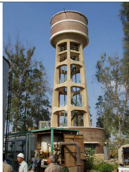
既設ヒヒヤ浄水場 井戸ポンプ施設
