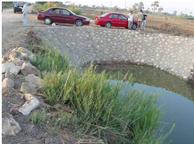
本計画浄水場建設予定地エントランス （NOPWASDにて施工済）
