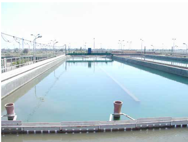
既設カフルサクル浄水場 横流式薬品沈殿池
