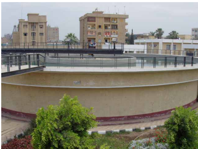
既設ザガジグ浄水場 上向流式薬品沈殿池
