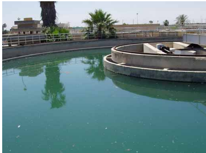
既設アバッサ浄水場 上向流式薬品沈殿池
