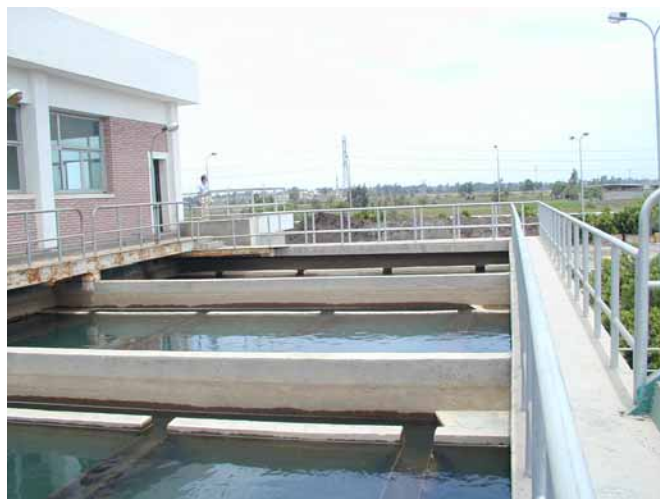
既設アバッサ浄水場 急速ろ過池
