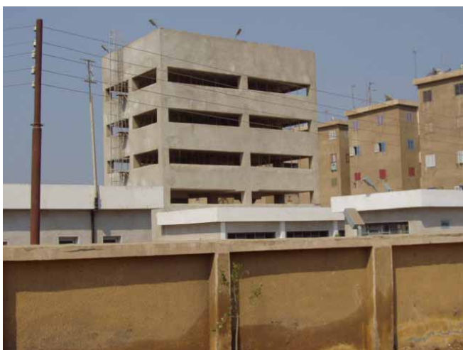
既設 鉄、マンガン除去プラント (シャルキーア県隣接メンア・エル・クオム市)
