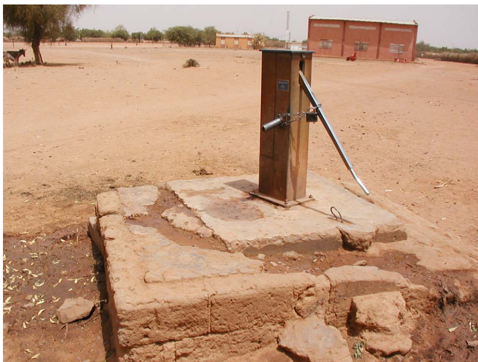
同上村の既設手押しポンプ付深井戸
