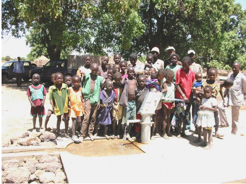
カチ・クリコロ・カンガバ地区給水計画で設置の手押しポンプ付深井戸
