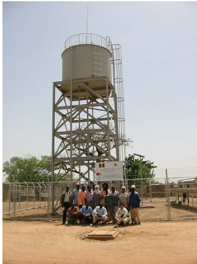
カチ・クリコロ・カンガバ地区給水計画で建設の小規模給水施設
