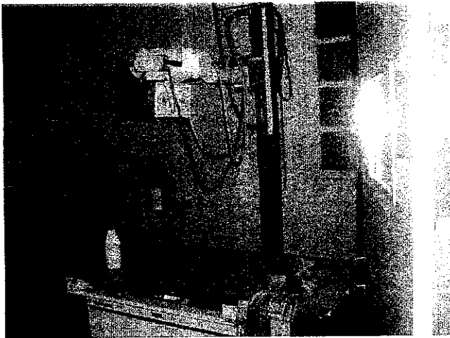
日本から供与した故障中の一般放射線撮影装置 (ペルティエ総合病院)
