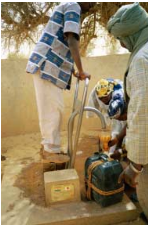
人力ポンプ（足踏ポンプ、高揚程型、日本が1997年～2000年にギニアウォーム撲滅プロジェクトで建設した井戸）。
