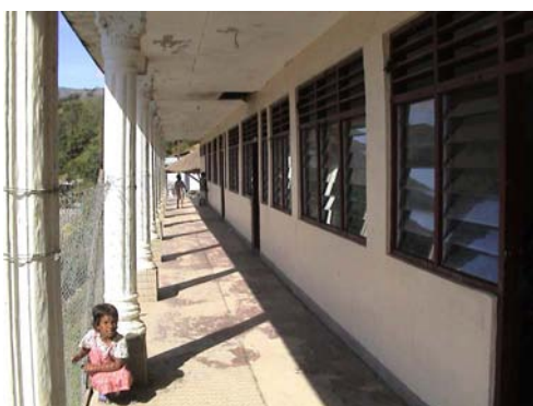
既存校舎廊下
