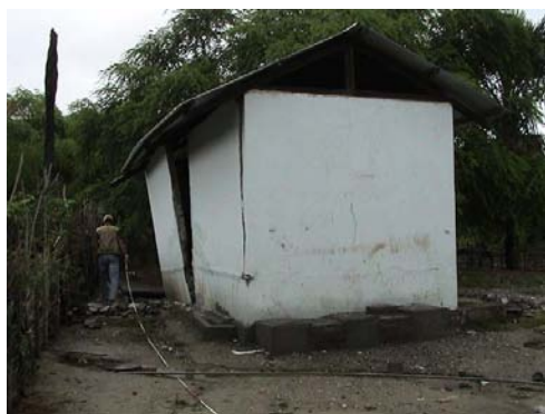
使用不能便所棟
