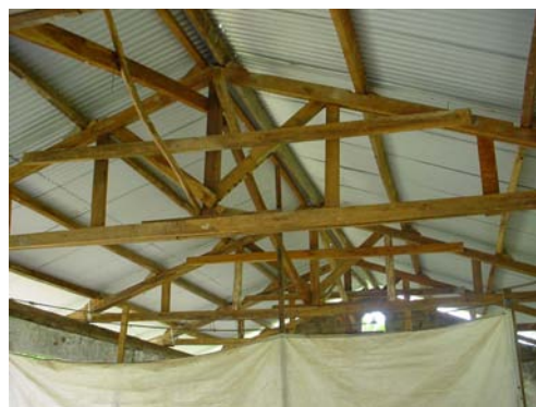
屋根構造と布製パーティション
