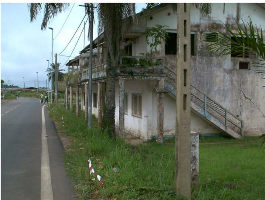
管理棟建設予定地
