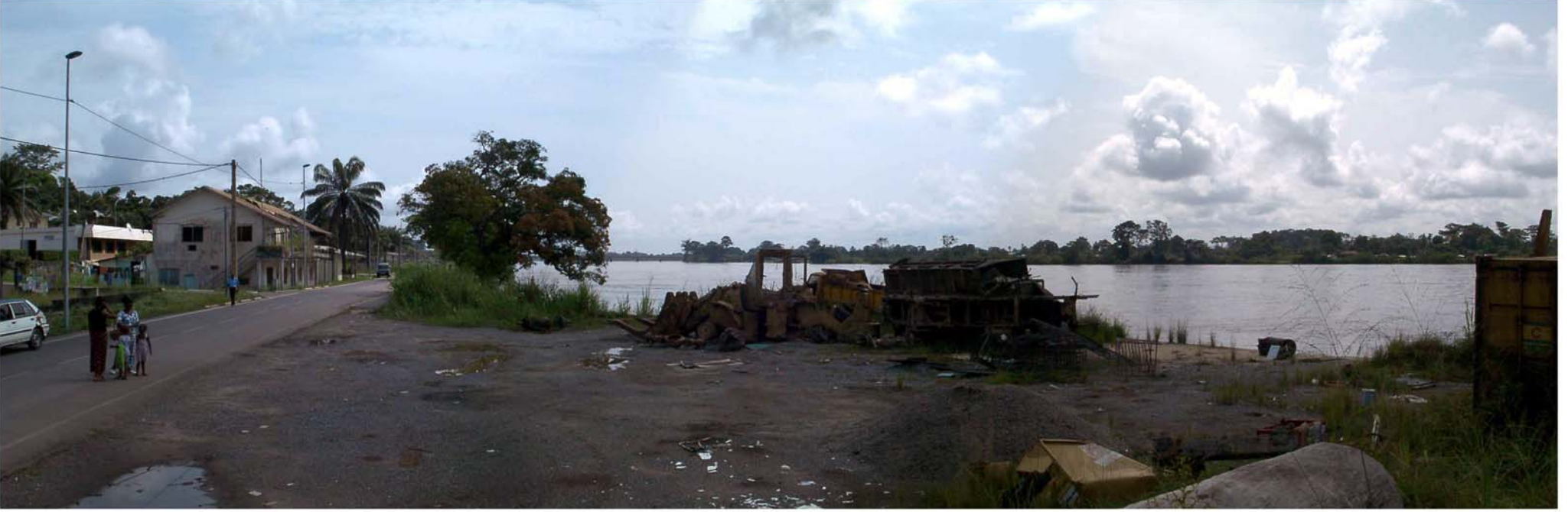
市場棟建設予定地全景
