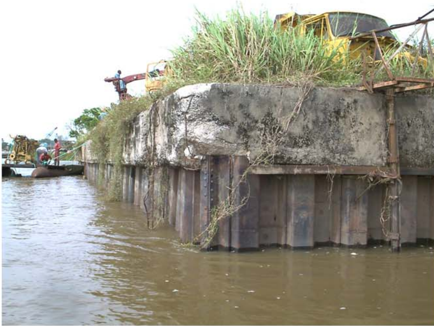
市場棟建設予定地にある既存 岸壁の状況
