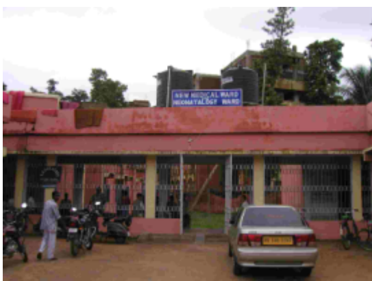
新内科病棟の外観 正面入口から少し歩いた左側に位置している。
