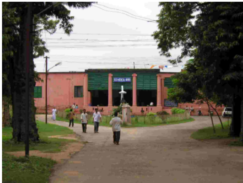
小児医療センター入口正面(旧内科病棟)の外観 各棟が分散されて機能的に配置されていないため患者の移送中の 事故等も起きている。
