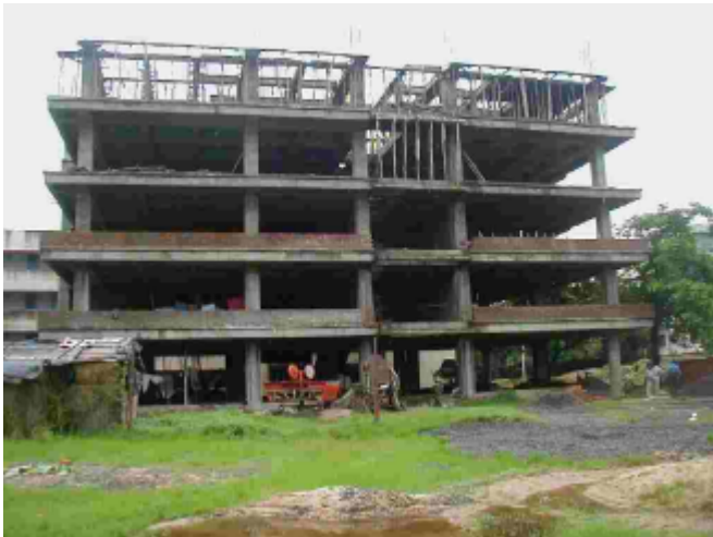
建設予定地に NICED が現在建設中の新棟
