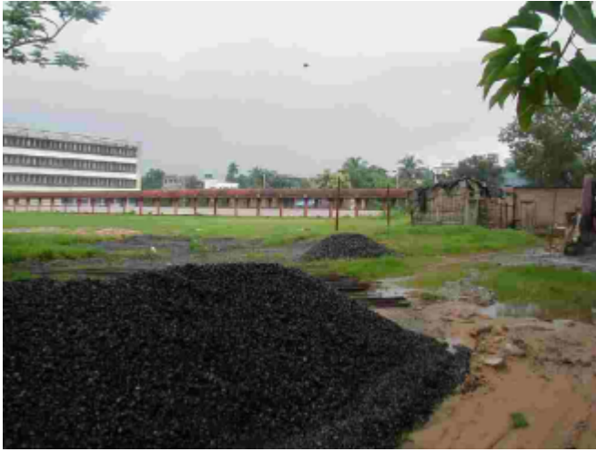
プロジェクトの建設予定地
