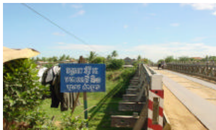
Takmau - Takeo 間 橋梁
