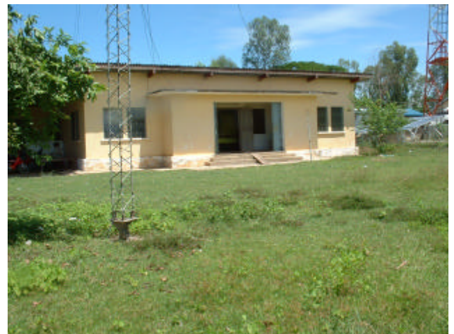
タケオ郵便局と電話設備用スペース
