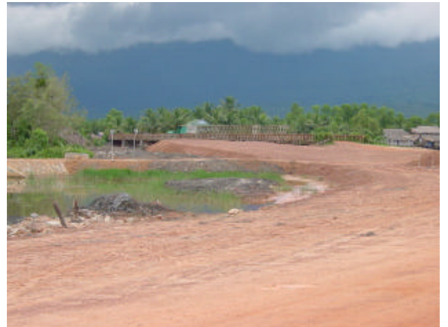
国道 3 号線 Veal Renh 付近 道路拡幅工事中
