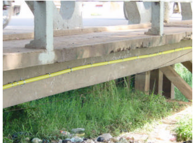
ケーブルを橋梁添架（PVC 管内収容）
