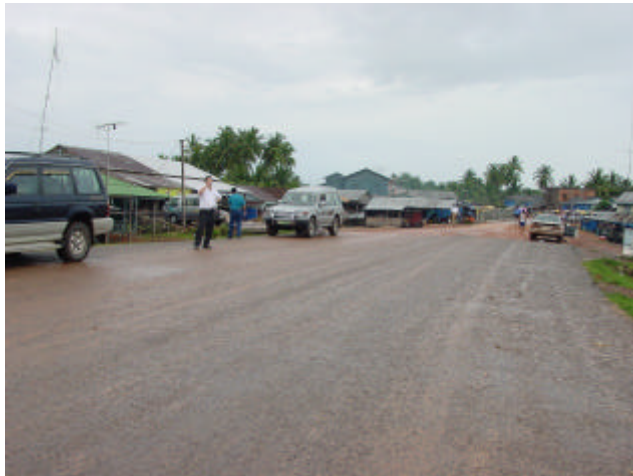
国道 3 号線 Prepeang Popeay 付近 道路拡幅し、舗装工事实施
