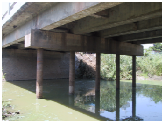
鋼管くいの腐食進行 中詰めコンクリートの劣化
