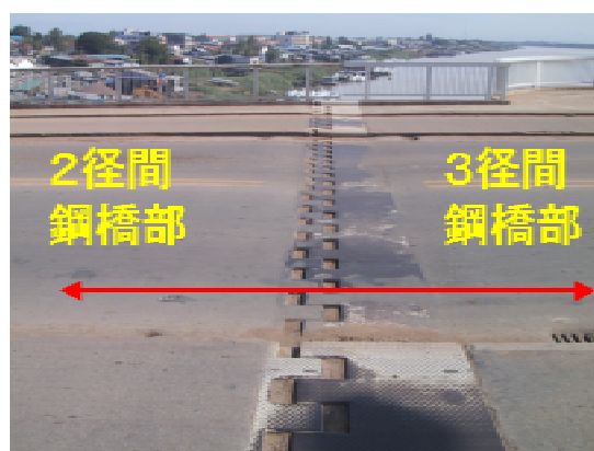
3 径間鋼橋部伸縮装置
