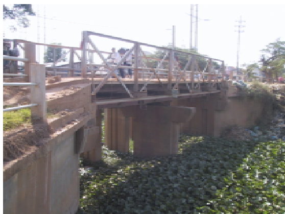
上部工：ベアリー橋 下部工は灌漑用施設の併用
