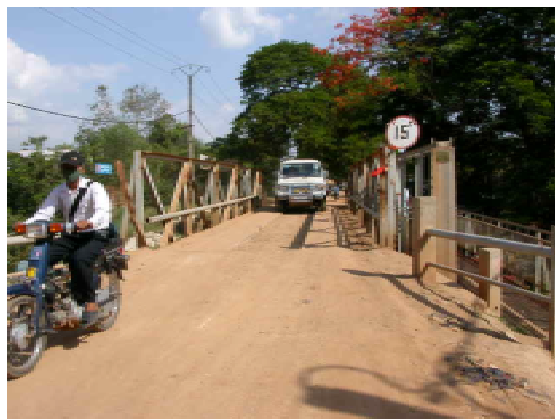
2002 年仏国が車道補強 制限荷重 15t へ改良
