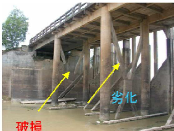
橋脚安定保持材劣化、破損
