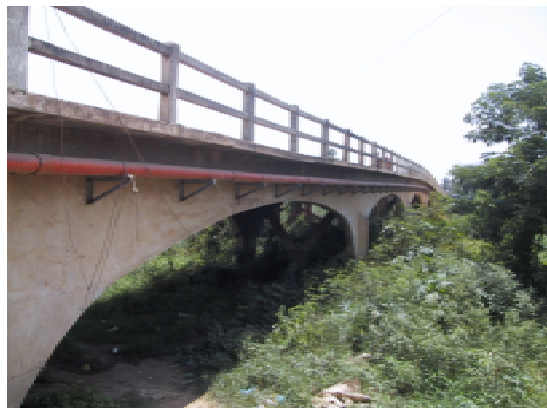
コンクリート橋：1922 年建設
