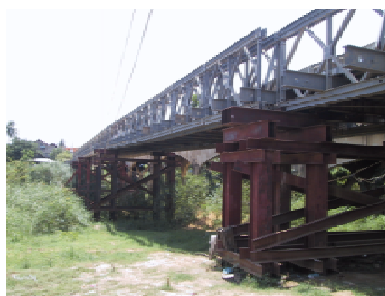
上流側に隣接するベアリー橋
