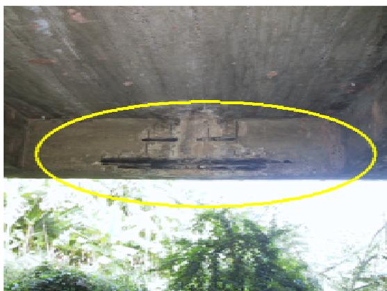
車道主桁部の鉄筋露出
