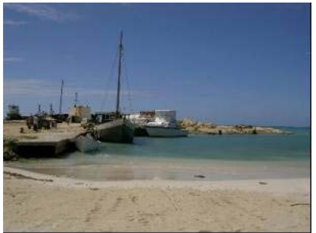
River 地区の既設突堤（砂積出・貨物用）
