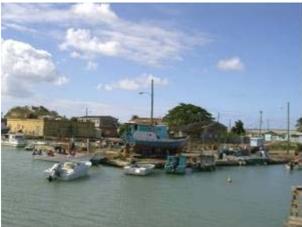
既設護岸・用地の状況
