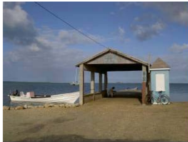
突堤及び小屋掛
