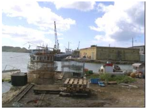
既設護岸・用地の状況
