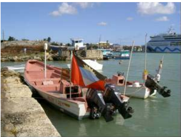
既設護岸・用地の状況
