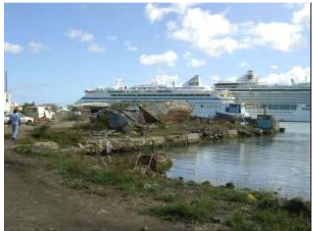
既設護岸・用地の状況
