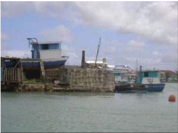
石積みのクレーン基礎跡
