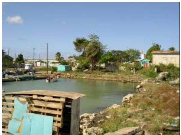
既設護岸・用地の状況
