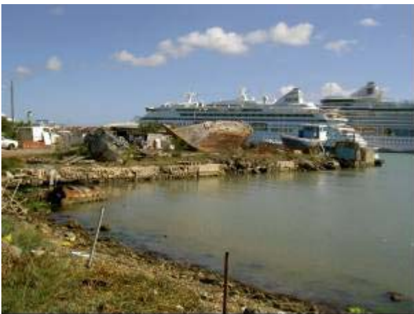
既設護岸・用地の状況
