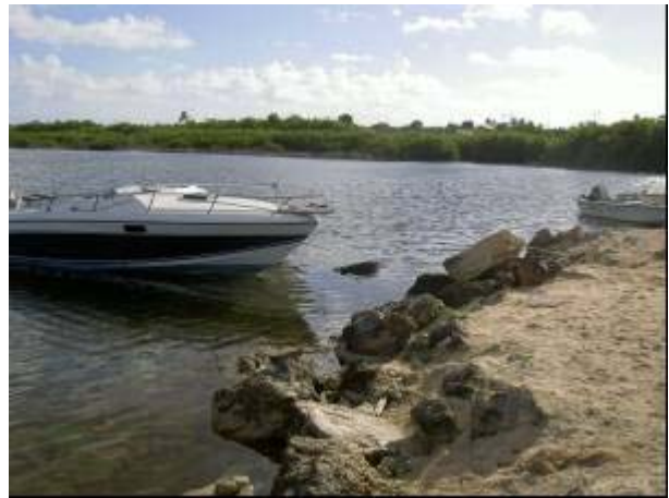
既設複合施設前の埋立護岸
