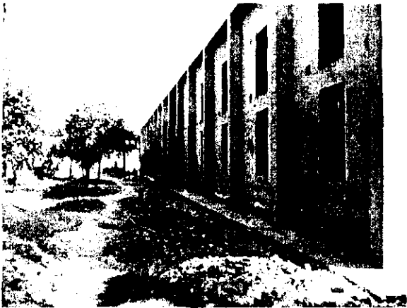
建築中の金型技術向上プロジェクト用建物
