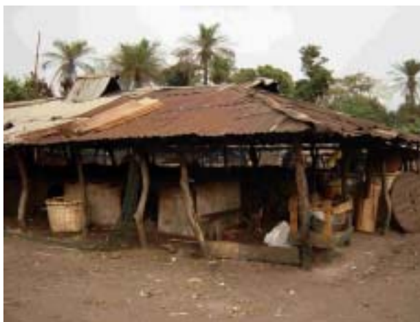
Photo 3. Fours Banda améliorés sous toit en tôle ondulée (Koukoudé)
