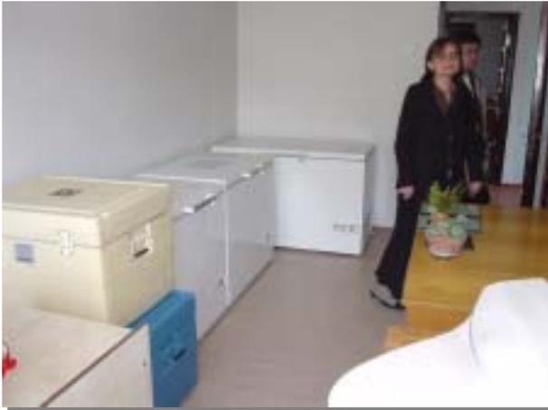
ムツハタ県公衆衛生局の保管用アイスライント冷蔵庫・冷凍庫（県の3ヵ月分のワクチンを保管）
