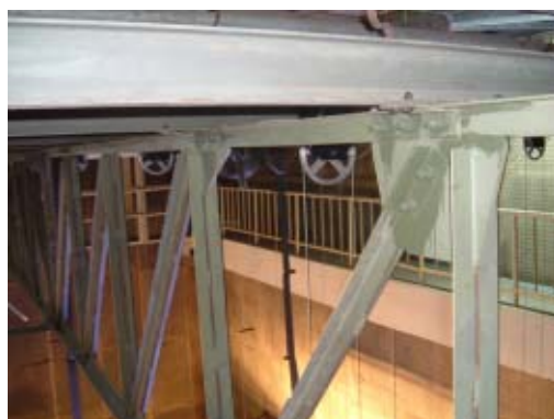
② 補強トラスの部材 補強トラスはアングル鋼材の組材で現 場での組み立てを考慮してボルト接合 となっている
