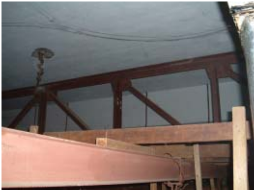
① 天井裏の既設鉄骨トラス 第2スタジオ天井裏に3本の鉄骨トラスが設置されており天井、換気ダクト、パイプ棚、照明器具等を支えている。
