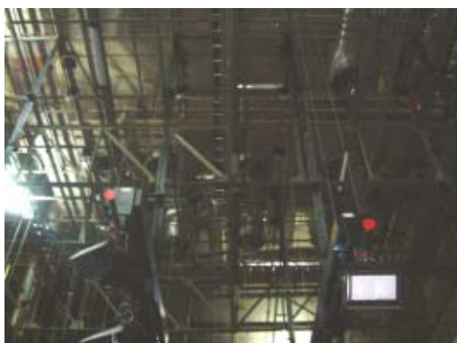
① 天井より吊り下げられた照明器具 上部に補強トラスを3本設置している
