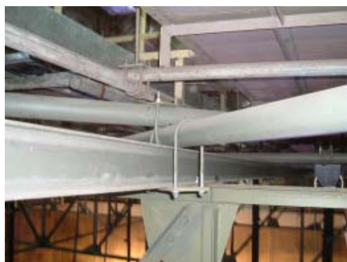
⑥ 補強トラスとパイプ棚の接合 トラス材の上にとパイプ棚を設け金物 とボルトで接合している。
