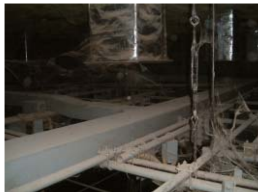
⑥ 吊材とパイプ棚の接合 吊材とパイプ棚は接合用金物で緊束されている。
