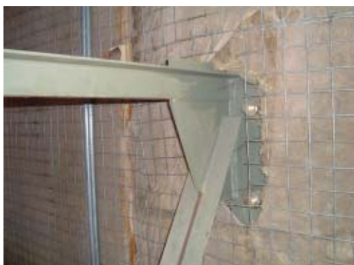
⑤ トラスと壁との接合部 補強トラスは壁にケミカルアンカーで 接合されている
