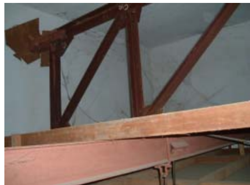
③ 既設トラスと壁の接合部 上材は補強材で壁の鉄板に溶接されており下弦材はコンクリート柱に乗せている。
