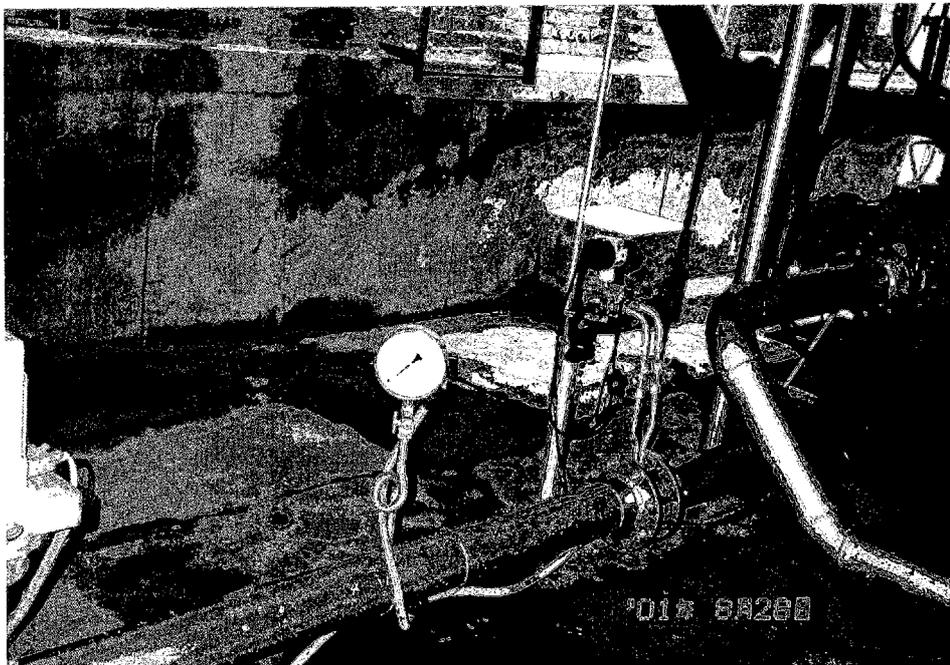
写真2 燃烧用空気送風管及び流量測定差圧発信器
