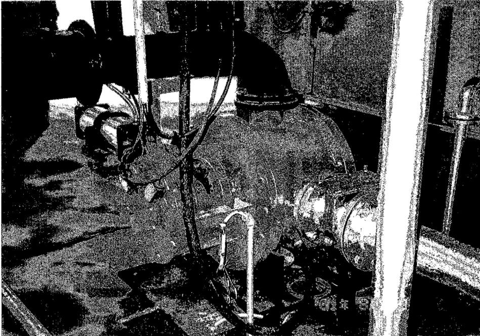
写真3 燃烧用空気及び燃烧排ガス切替弁1
