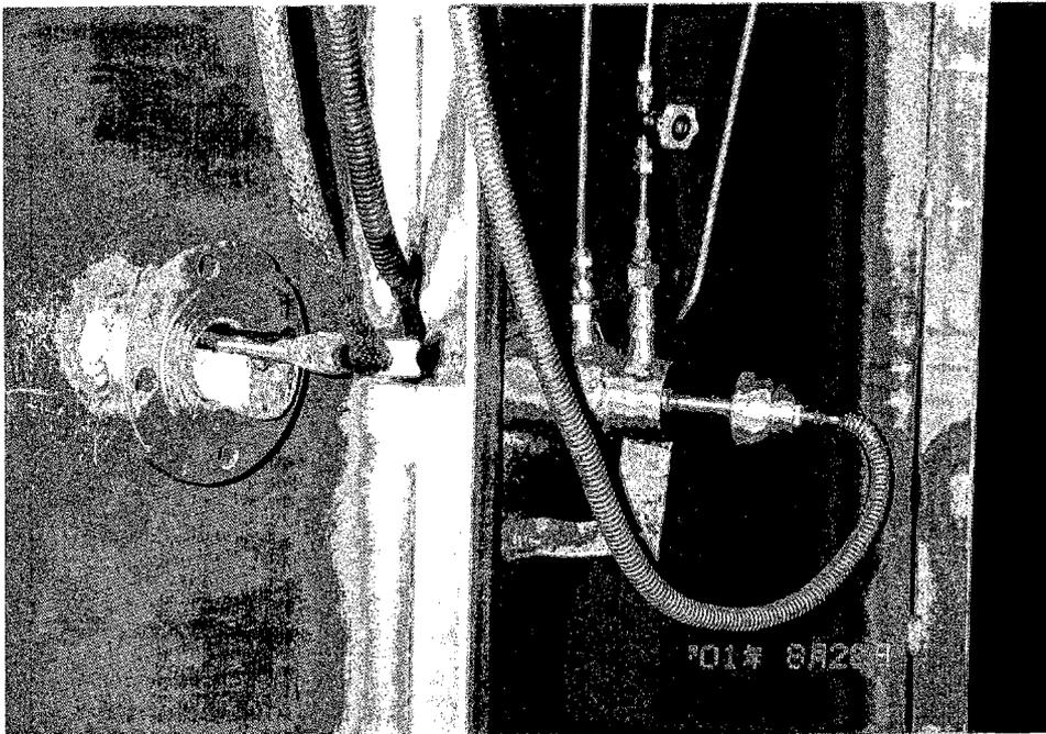
写真8 昇温用補助バーナ（油焚き）及びガスサンプリングポート
