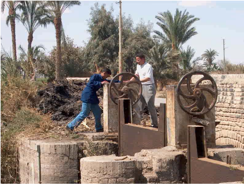
サコーラ堰上流から取水するハリカ重力灌漑取水工ゲート操作風景：
