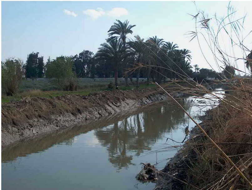
同上、バハナサ支線水路浚渫直後：
