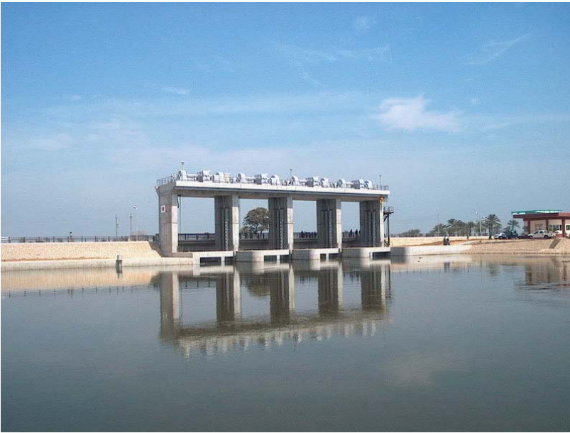
2002年に改修されたマゾーラ堰（上流側より）：
