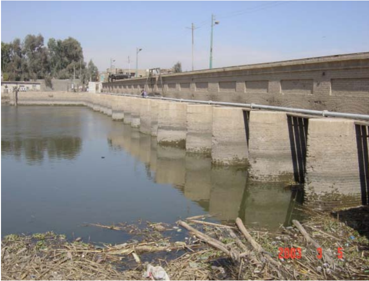
既設サコーラ堰全景（右岸上流より）：
