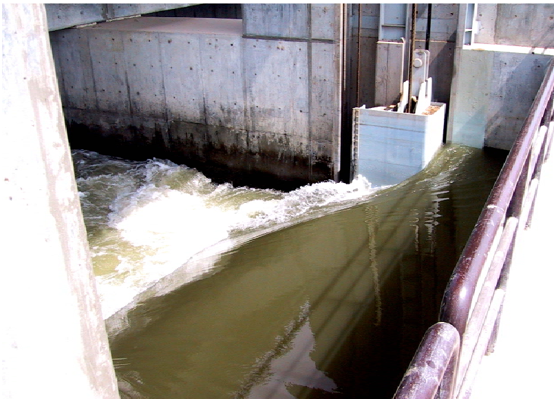
マゾーラ堰上段ゲートからのオーバーフローによる下流放流：
