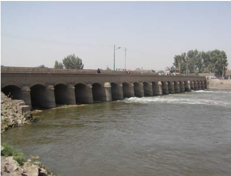
同堰全景（右岸下流側より）：
