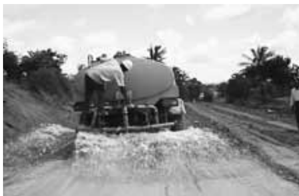
写真 6 1 陰イオンに特殊材の散布（転圧前）
