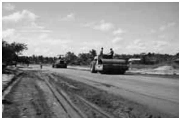
写真 6 2 陰イオンに特殊材の散布の転圧前
