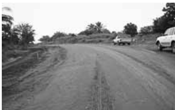
写真 6 3 転圧後の状態
