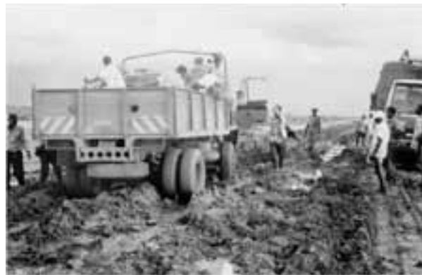
写真 2 36 雨上がり後の道路工事現場
