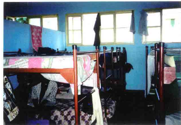
男子学生寮内部。天井が高く、両方向の壁に設けられた木製サッシを開け放し自然換気を行っている。
