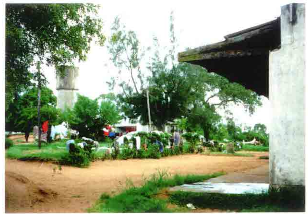
学校入り口付近の女子学生寮前の庭は洗濯場及び干し場となっている。外部との接点に女性の洗濯物が干されることは好ましくない。
