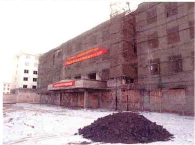
建設中の新キャンパス、教学棟
