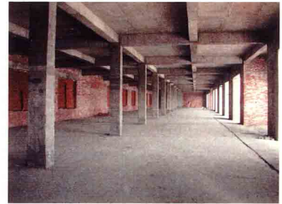
建設中の新実習棟内部
