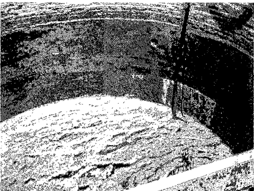
皮革工場（カネローネス県）：排水処理槽
