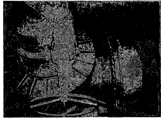
モンテヴィデオ県下水処理場： 海底放流ポンプ
