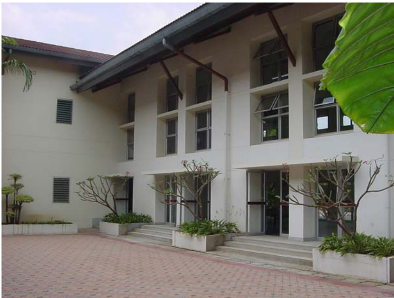
アセアン保健センターの建物。 日本の無償援助による建物である。
