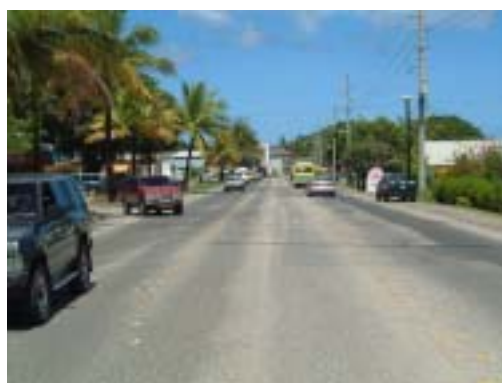
写真 3-2 道路中心側での付加車線運用
