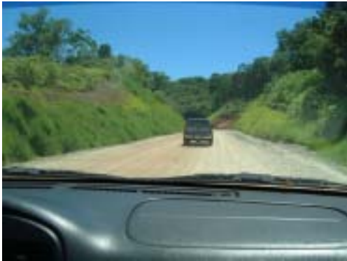
コンパクト道路の切土区間。環境対策のために植栽されている。
