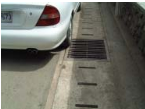
マラカル区間に敷設されていた U 字側溝
