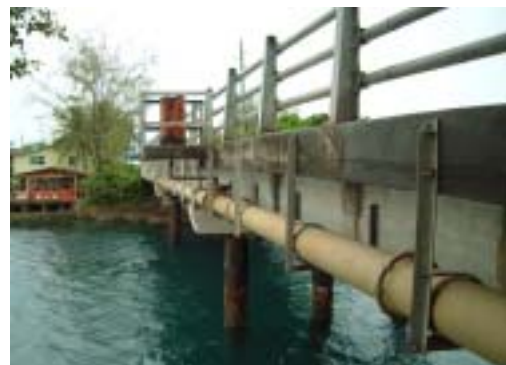
上水管及び下水管が添加されている。
