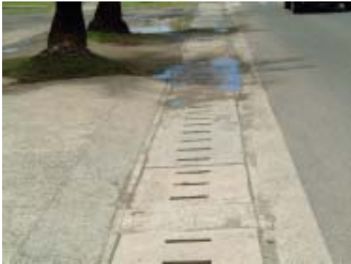
コロール中心部に敷設されている U 字側溝 (局部的) ポイント-5 ~ ポイント-8
