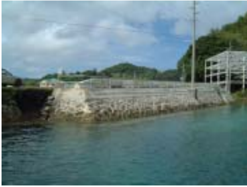
改良区間の全体ビュー
