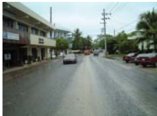
市内の典型的な道路断面 (パレイシ アホテル前)。歩道がほとんどなく、 側溝も敷設されている区間とない区 間があり不規則。
