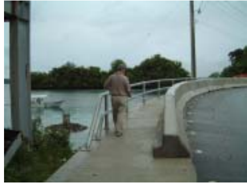
改良された歩道部
