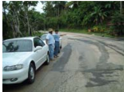
ポイント-12 ~ 13 区間での地すべり区間（上水道、下水道管が埋設されている）
