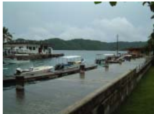
マラカルの港湾施設の一部。商業港湾としてはここだけで重要な施設。
