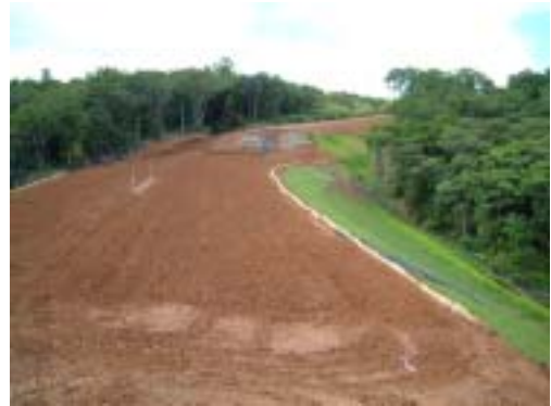
コンパクト道路の盛土区間。環境対策のために植栽されている。
