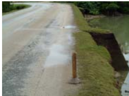
道路端に敷設された誘導・安全装置。 この区間のコースウェイは非常に狭く、路肩を入れても車道部は 3.0m しかない。
