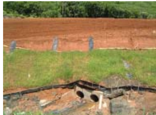
様々な環境対策が施されている。土を流出させないためのジオ・テキスタイルが見える。
