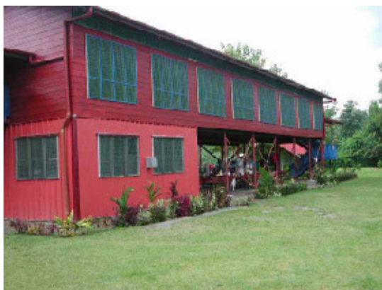
23. 研修生宿泊施設（オイスカ研修センター）
