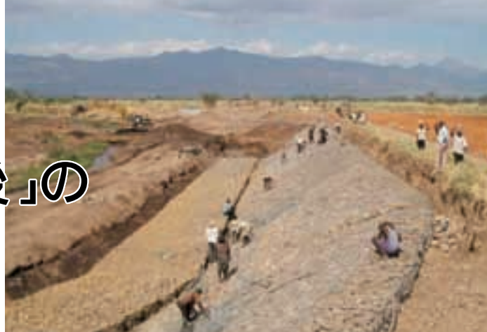
フォローアップによるかんがい施設の修復工事現場(マラウイ)
