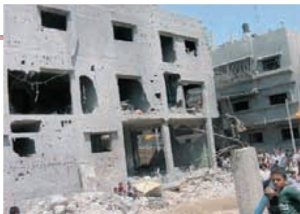
パレスチナの紛争で破壊された建物
